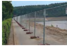
Baustellen- und Verkehrssicherung
