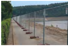
Erd-, Tief- & Straßenbau
